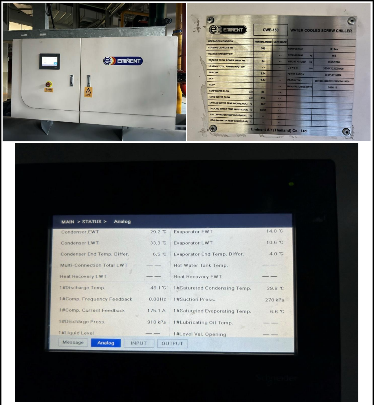
รูปที่ 5-1 ภาพก่อนดำเนินการปรับปรุง
