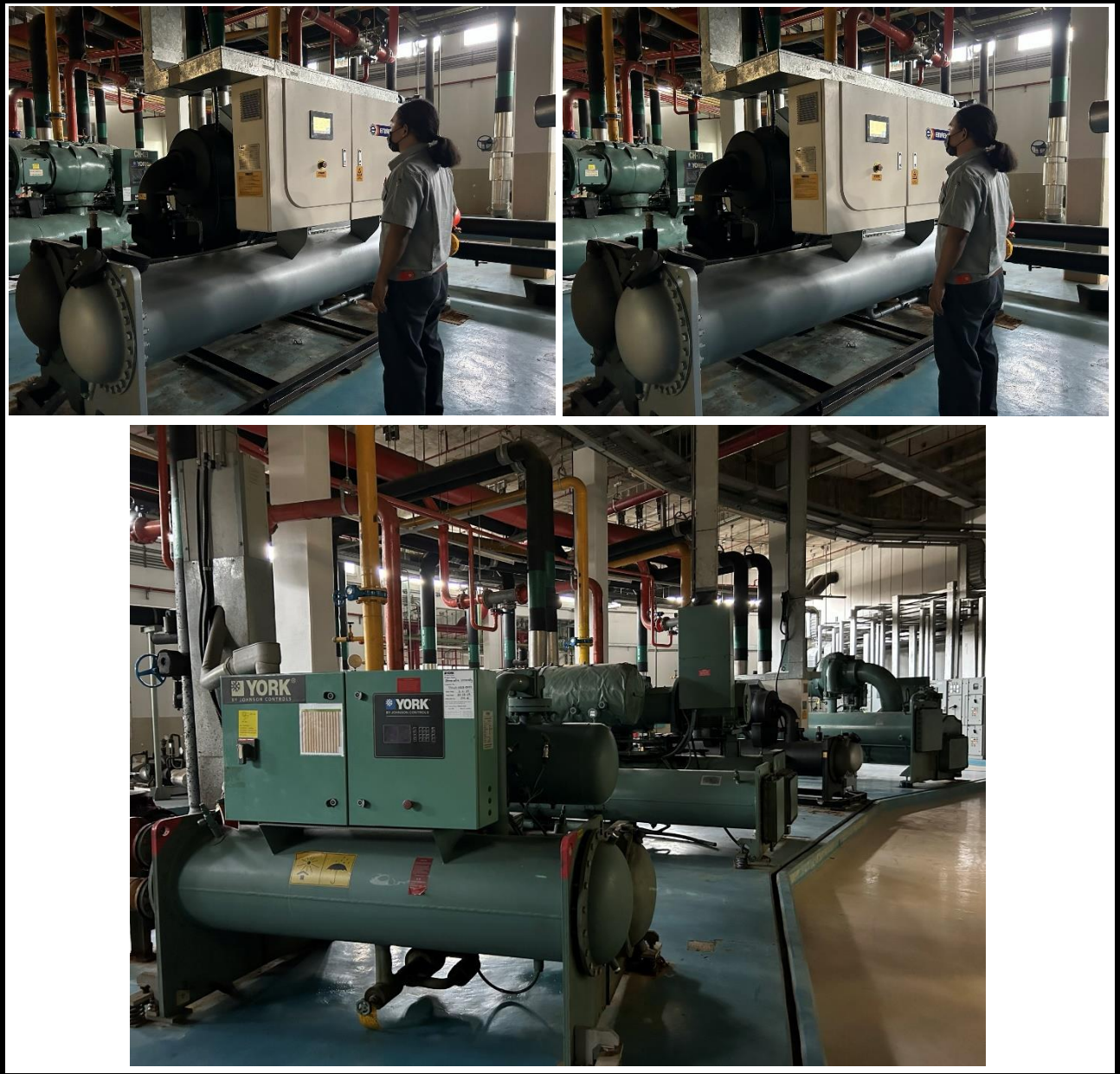
รูปที่ 6-1 หลังดำเนินการปรับปรุง
