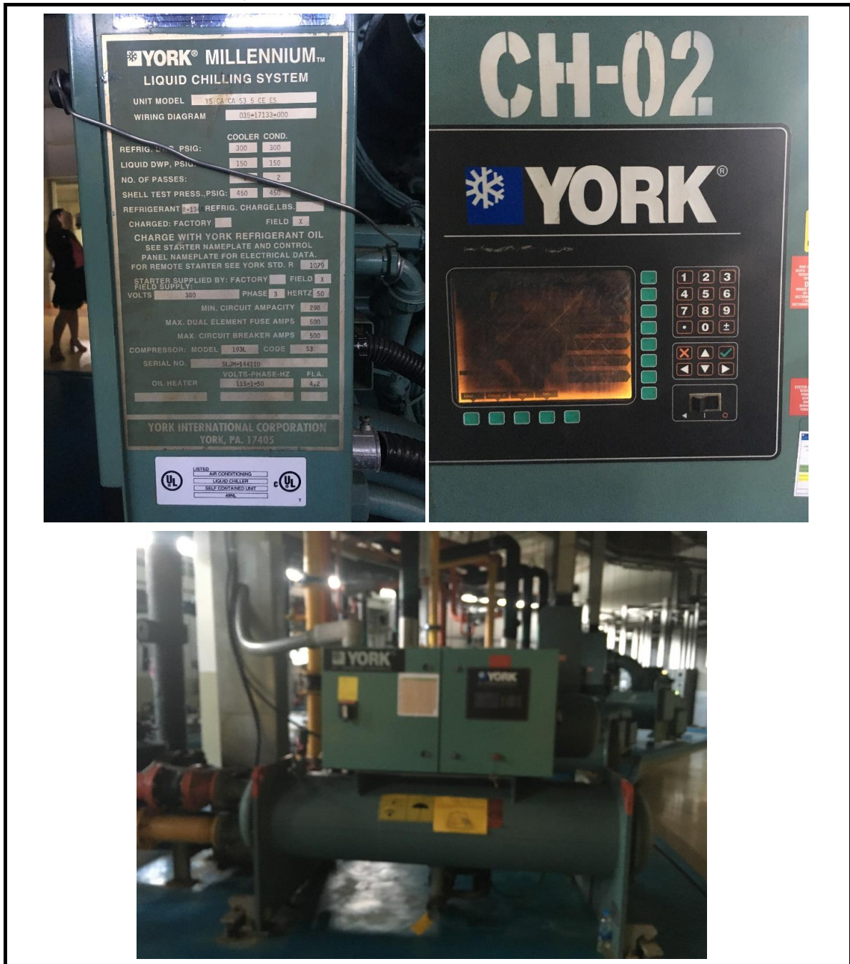
รูปที่ 5-2 ภาพก่อนดำเนินการปรับปรุง
