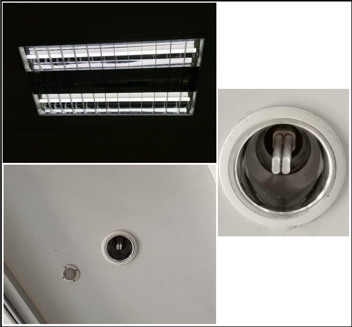
รูปที่ 5-1 ภาพก่อนดำเนินการปรับปรุง
